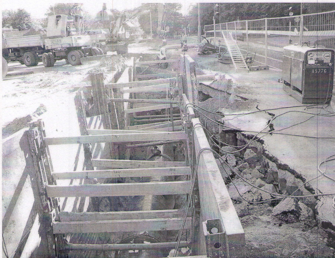
Rys. 2. Degradacja nawierzchni w pobliżu wykopu
