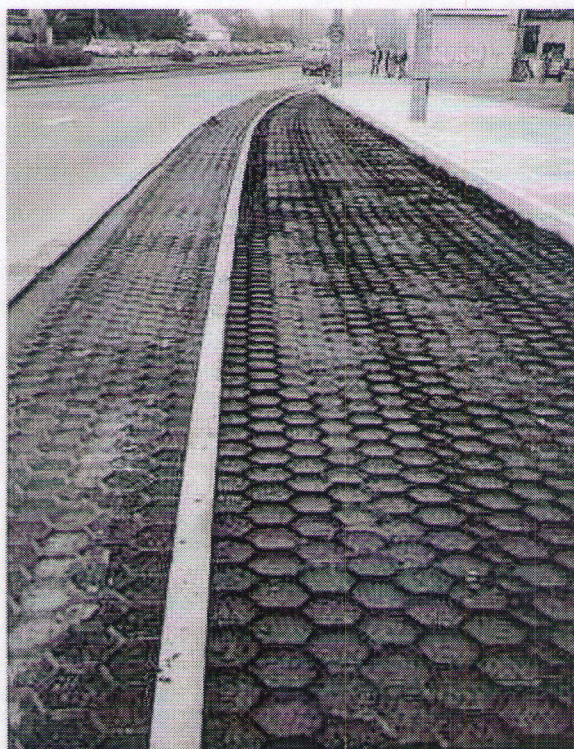
Rys. 11. Przykład zastosowania technologii METALFLEX® na przystanku autobusowym na terenie miasta Poznania
